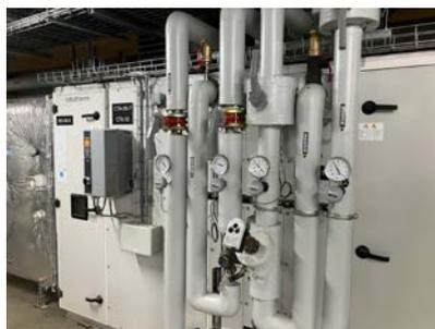
Les centrales de traitement de l'air – en intérieur – facilitent la maintenance et assurent la filtration d'un air extérieur plutôt pollué.
