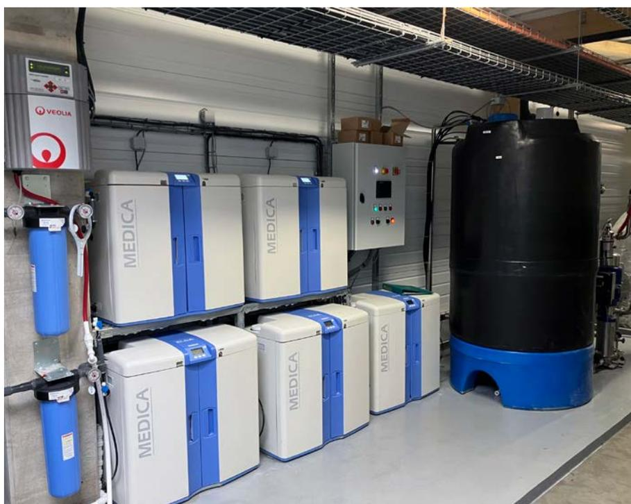
La production d'eau purifiée est centralisée à l'étage. Fini les manipulations pour la maintenance des osmoseurs de chacun des automates !
